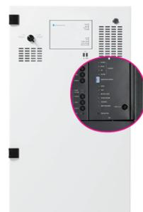
Блок управления всей станцией. Выполняет все функции управления и контроля. О правильной работе станции информируют светодиоды, расположенные на передней панели. Отвечает за: измерение тока заряда и разряда батареи, напряжения батареи, напряжения симметрии аккумулятора, амплитуды напряжения питания, внутренней температуры системы и взаимодействия с пользователем путем отображения информации о состоянии системы.
